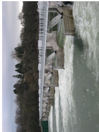
Image 5. Passerelle en hauteur avec bracons sur piles Barrage de Pontoise (AEI) Gauche Image 6. Passerelle en hauteur avec structure droite : Barrage de Givet (AEI) droite
