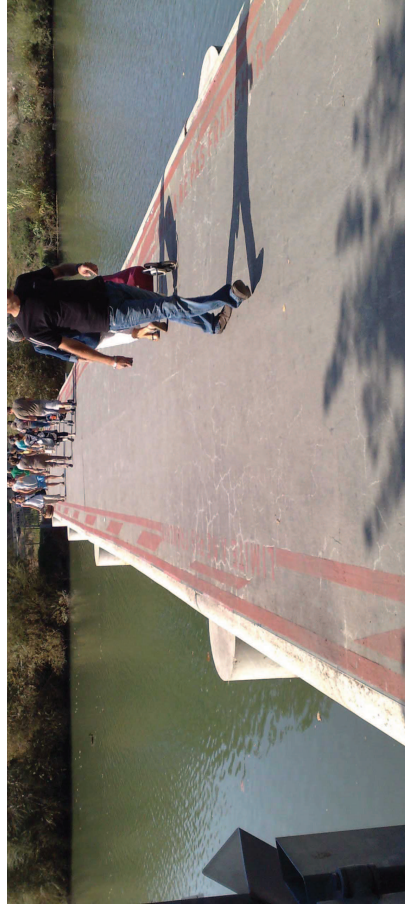
Image 2. Passerelle submersible sans garde-corps sur le Vidourle (cours d'eau à caractère torrentiel) à Sommières
