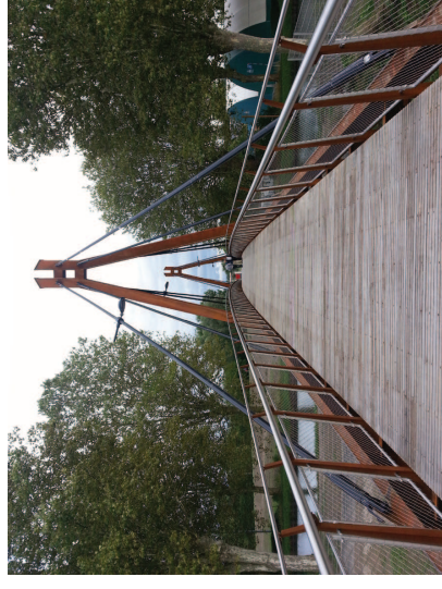
Image 11. Passerelle d'Eschau, Architecte : AEI L'acier autopatinable de type Corten :
