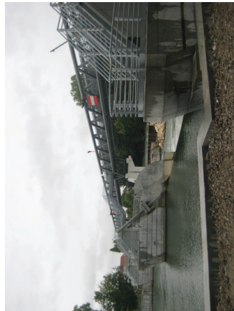
Image 5. Passerelle en hauteur avec bracons sur piles Barrage de Pontoise (AEI) Gauche Image 6. Passerelle en hauteur avec structure droite : Barrage de Givet (AEI) droite
